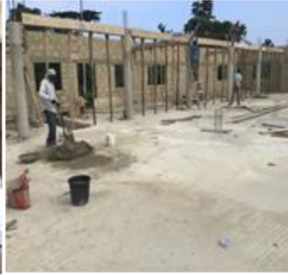
Schulmensa im Bau
