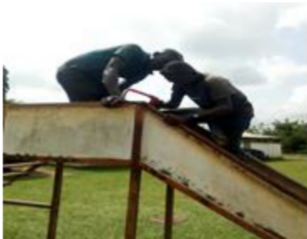
Instandsetzung der Rutsche
